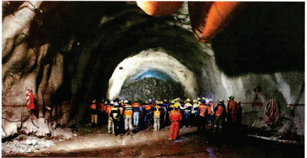
Túnel subterráneo en la División Chuquicamata. FOTO CODELCO
